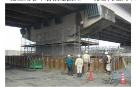
あきる野市内の多摩川 に架かる睦橋の橋脚の 耐震補強を行う工事で す。既設の橋脚に鉄筋コ ンクリートを巻き立て 耐震補強する工事内容 です。パトロールに伺っ た日は、立孔内に足場を 組む作業を施工して
