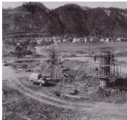
写真③ 堰下橋下部工事
