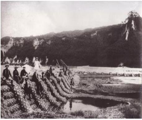
写真① 丸山下護岸並びに水制工補修風景 明治末期
