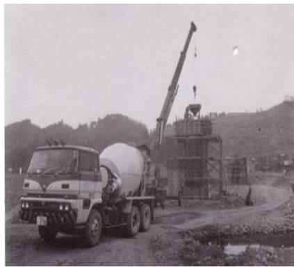
写真④ 橋脚コンクリート打設状況
