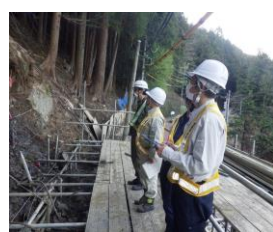
法面現場確認
