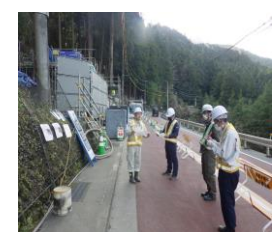
工事概要確認
