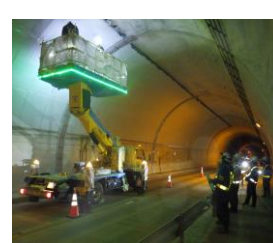
トンネル内パトロール
